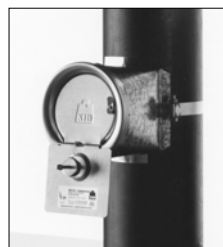
Trækstabilisator på lodret røgrør
